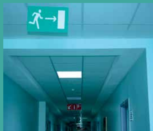
Рис. 7. Знаки выхода по пожарной безопасности и указатели на огнетушители.
