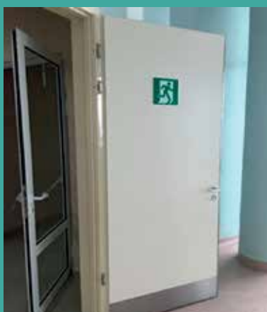
Рис. 6. Двери, ограничивающие пожарные зоны, должны быть прикрыты
